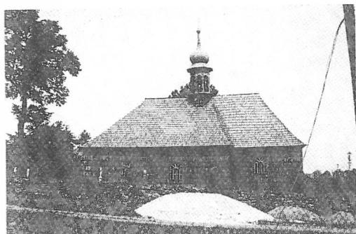
Holz-Schindelkirche in Lindenau (Aufnahme 1983) Geweiht dem Hl. Johannes d. Täufer
