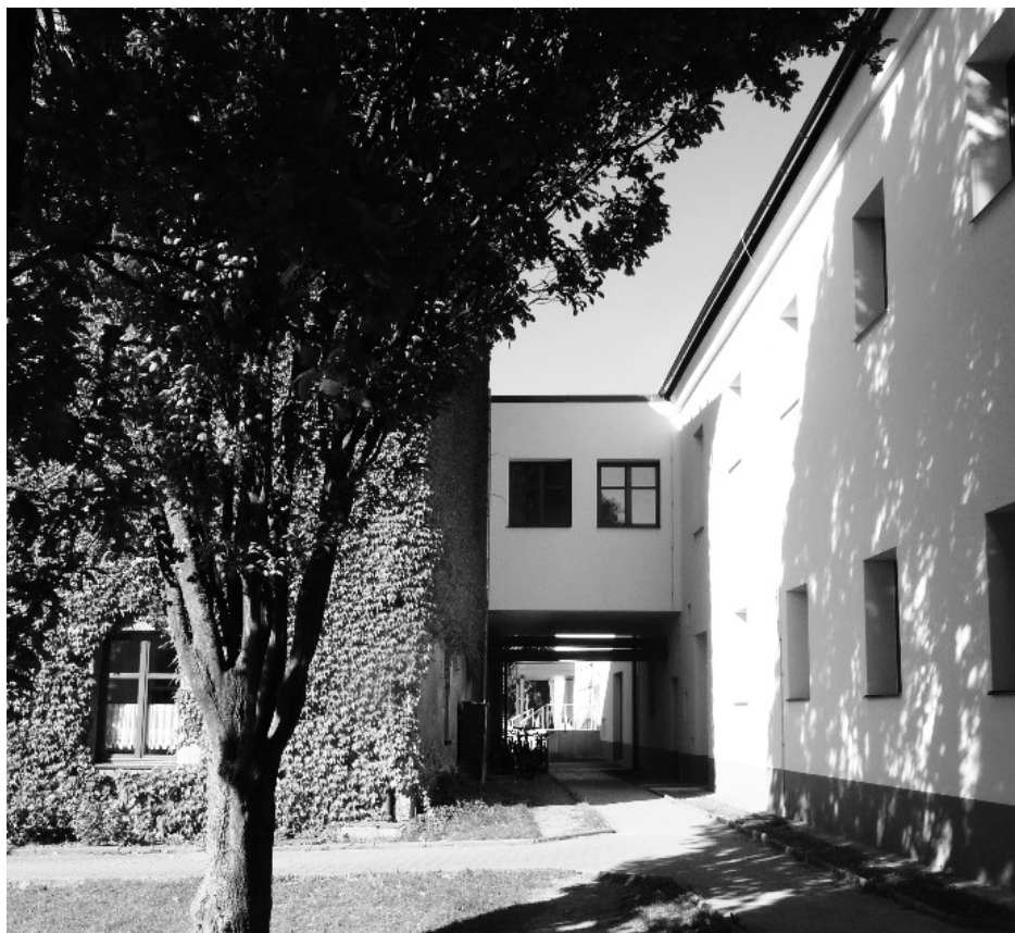
Pohled na přístavbu z čelní strany školy od parku (Foto: J. Šustková, říjen 2023)
