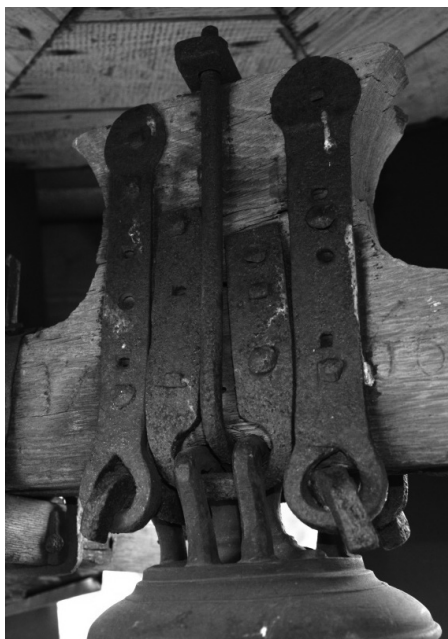
Obr. 7: Detail upevnění korunních uch na zvonové hlavě (Foto: J. Hynčica, 2022)
