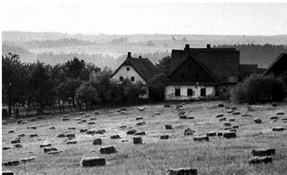
V roce 1978 je patrné chátrání budovy obydlí bývalého šafáře č. p. 77, které bylo do roku 1981 zcela zbouráno a odstraněno. (Archiv manželů Šumných)
