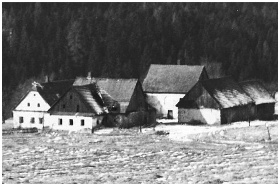
Nový Dvůr v roce 1975, do popředí vystupuje obydlí č.p. 77, pod ním popisné číslo 76, v pozadí budova č. p. 75. (Archiv manželů Šumných)
