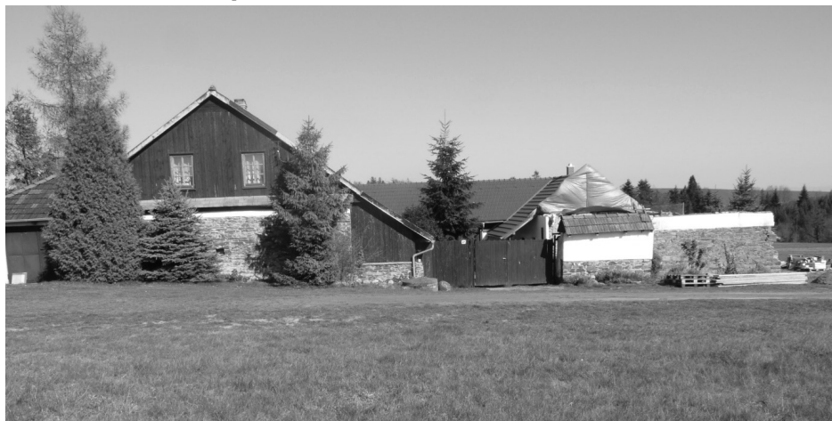
Hilbrovice 2020. Dům č. ev. 11 - bývalá selská usedlost čp. 48. Foto Jaroslava Šustkové
