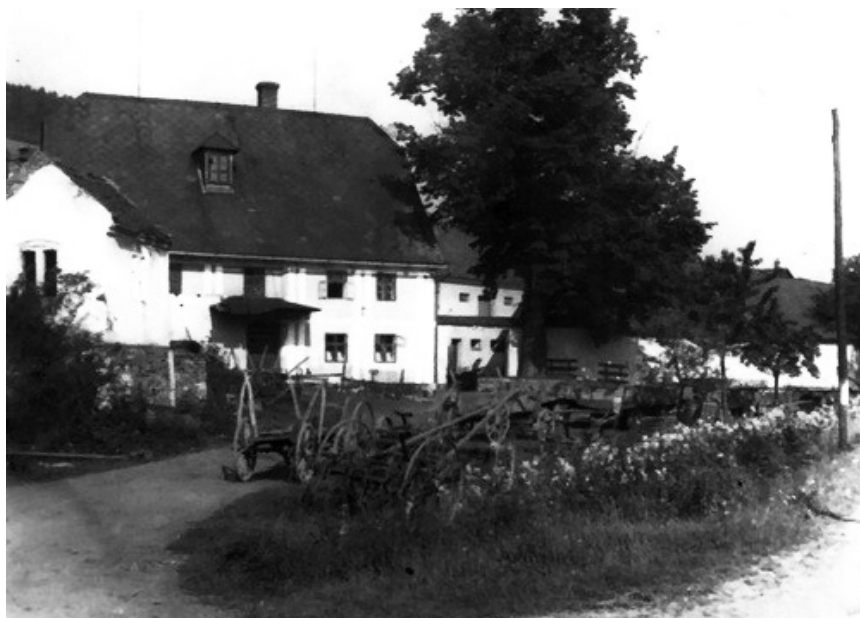
Mlýn z období 50. let, kdy hosp. budovy byly v pronájmu JZD a takhle vypadal tzv. "vozový park"
