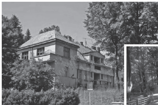
Klokočov 2015. Historická budova №. 59 - část zámku klokočovského panství. Foto Ulrich Mir.
