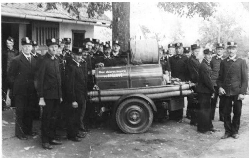
Hasičská stříkačka a někteří členové SDH v roce 1936. Tato stříkačka byla součástí výstavy i v letošním roce. Poznáte na historickém snímku hasiče?
