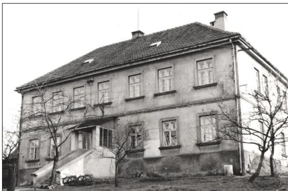
Budova č. 57 okolo roku 1970 s původním vchodem. (Foto: J. Šustek)
