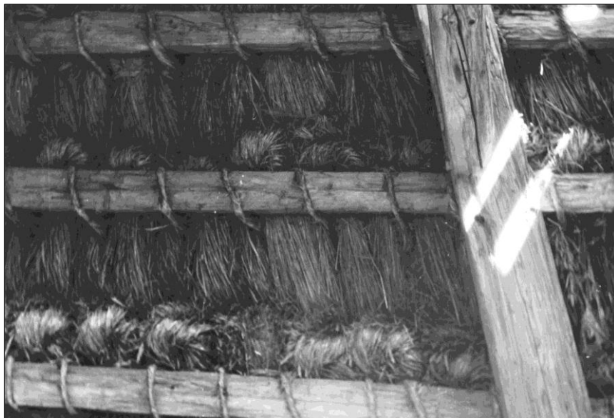
Spálov, grunt č. 13, došková střecha na srúku z r. 1595
