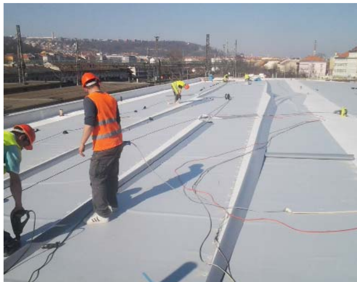
Střecha nádraží ČD Praha Smíchov
